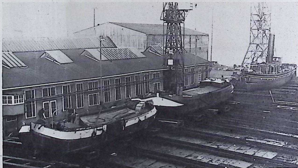
Reparatiehelling 1 begin januari 1972
