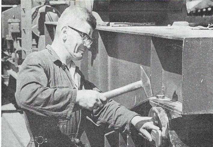
Onderhoud aan torenkraan. P. v. Raak in actie met torenkraan 9.
