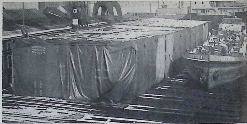
De Hochtief I en II kampeerden op helling I. Ze werden gestraald, geveerd en voorzien van versterkingen voor het plaatsen van draglines.
