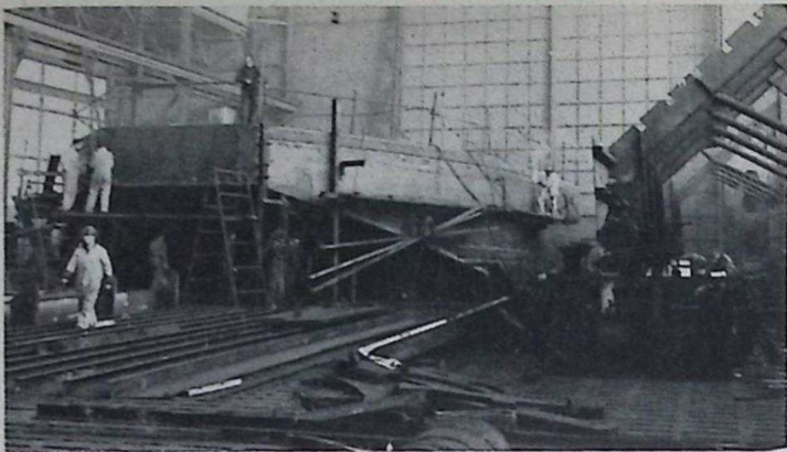
„Llesbosch"-sectles in de lasloods. Vier stuks van 20 m. en \pm 120 ton per stuk. (CO 9909)
