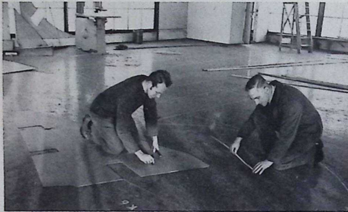
H. Slegt met zijn maat H. v. Ruynen (volontair) maken mallen voor de achterstevens onder CO 9775.
