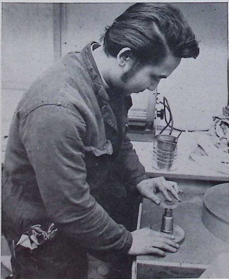
Aan de lapmaster, d.i. gereedschap voor het fijn slijpen van kleppen.
