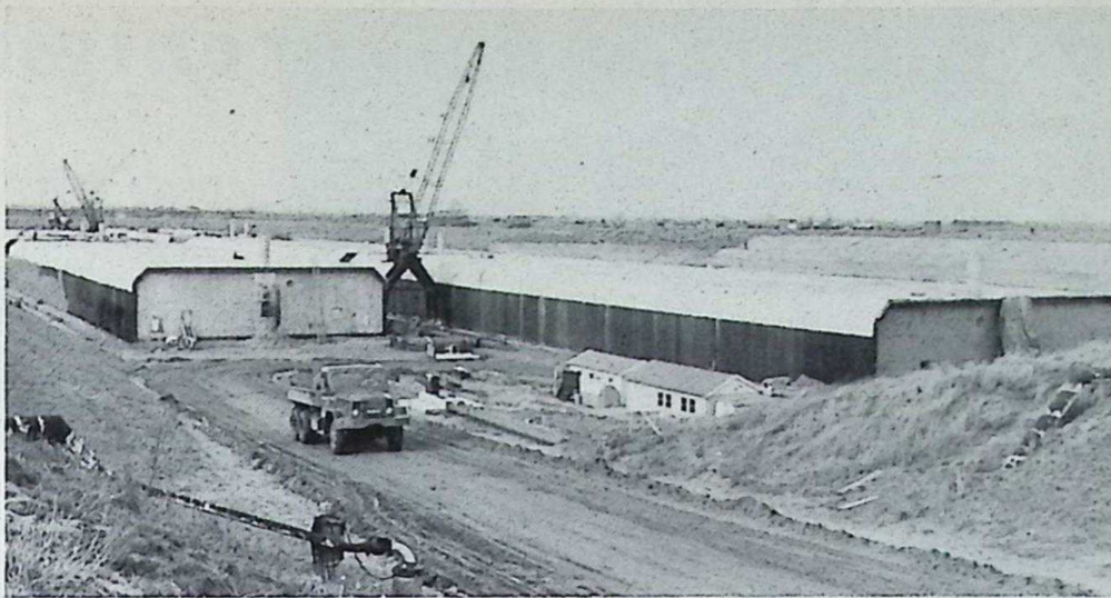
Dit zijn de tunnelsegmenten, die straks uit de bouwput gevaren moeten worden.
