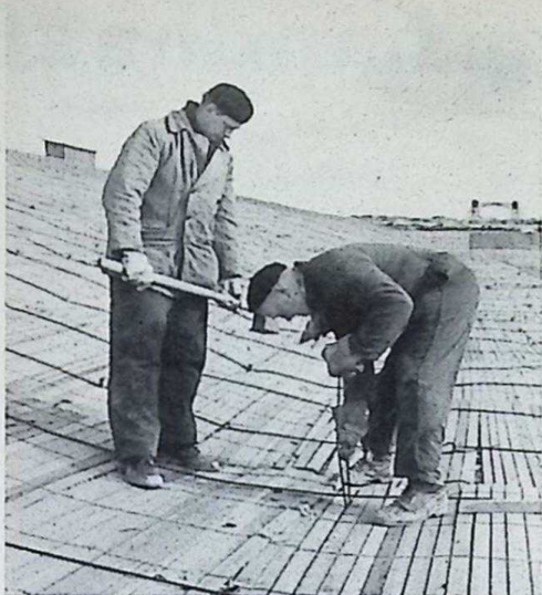
Arbeiders zijn reeds bezig met het beschermen van de binnenzijde der bouwputdijken.
