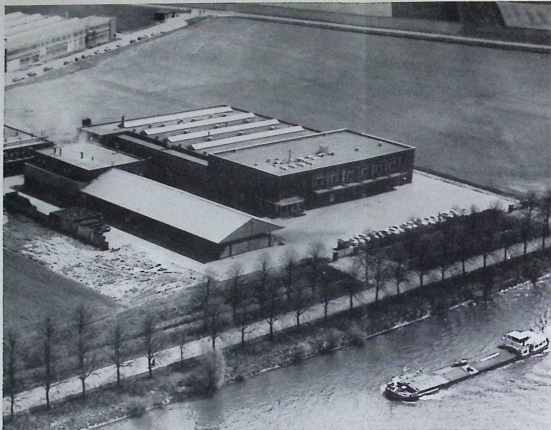
Smit Nijmegen, Nederlands pionier op lasgebied. In de voorste gebouwen worden elektroden vervaardigd, in de achterste laspoeder. Het water in de voorgrond is het Maas-Waalkanaal.
