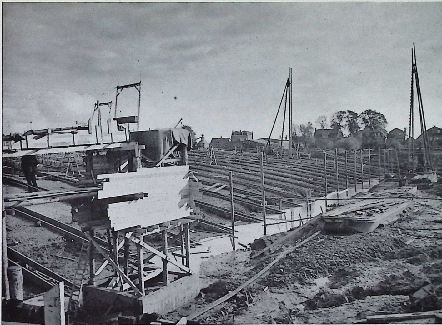
De nieuwe dwarshelling in aanbouw
