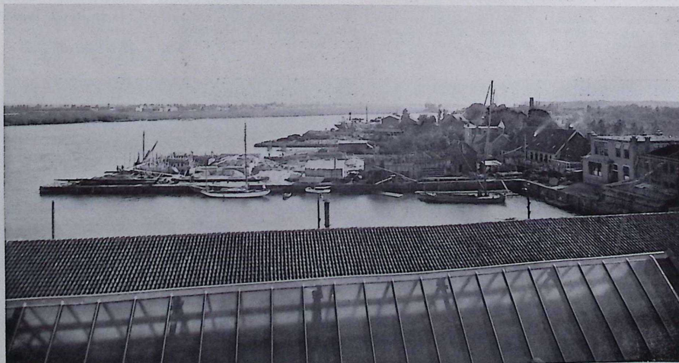
Machinefabriek in aanbouw. 1919
