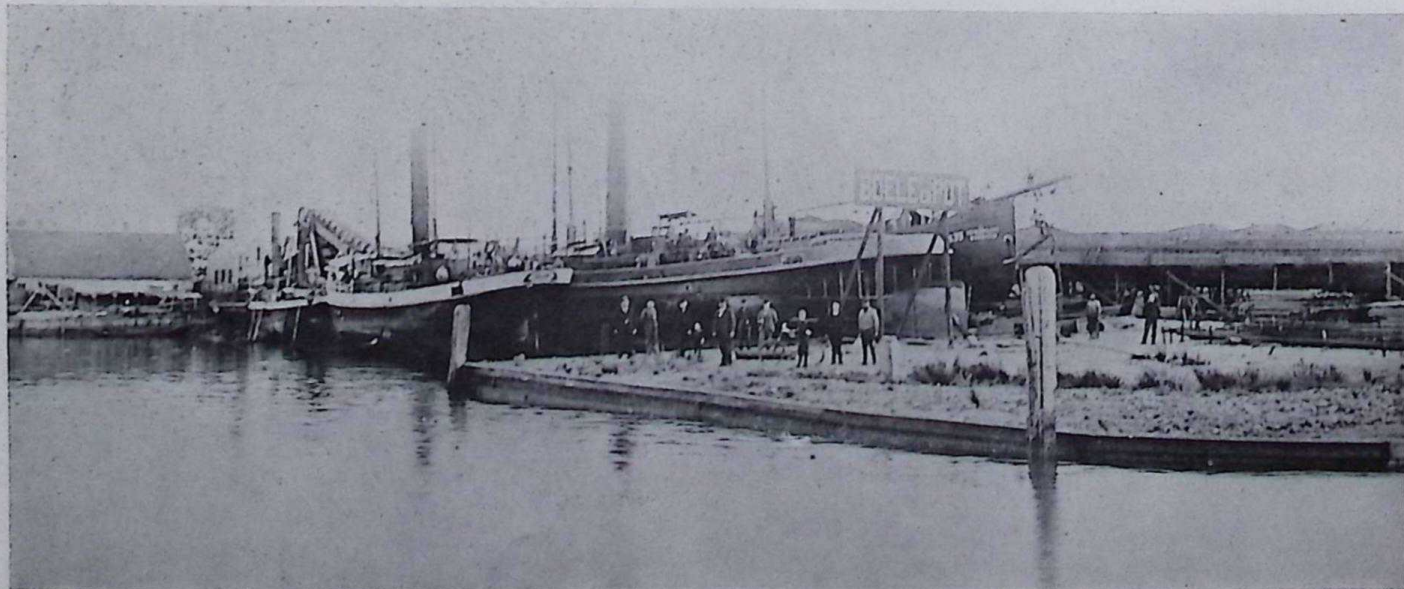
Foto omstreeks 1898. De ingang werf is nog op dezelfde plaats. Links ziet men, op de plaats van het tegenwoordige bedrijfskantoor, arbeiderswoningen en rechts het kantoor met lierenwerkplaats. De ijzerloods was er nog niet. Op de voorgrond de heer M. P. Boele met zijn zoon J. P. Boele (met fiets)
