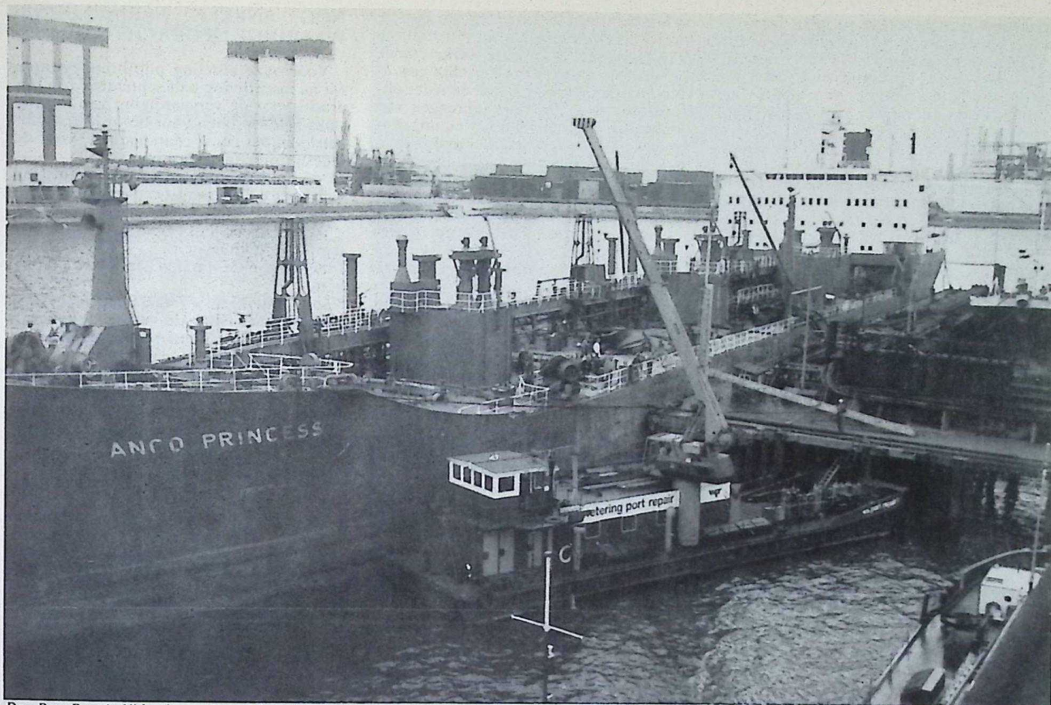
De „Port Repair I” haalt een lier van boord.
