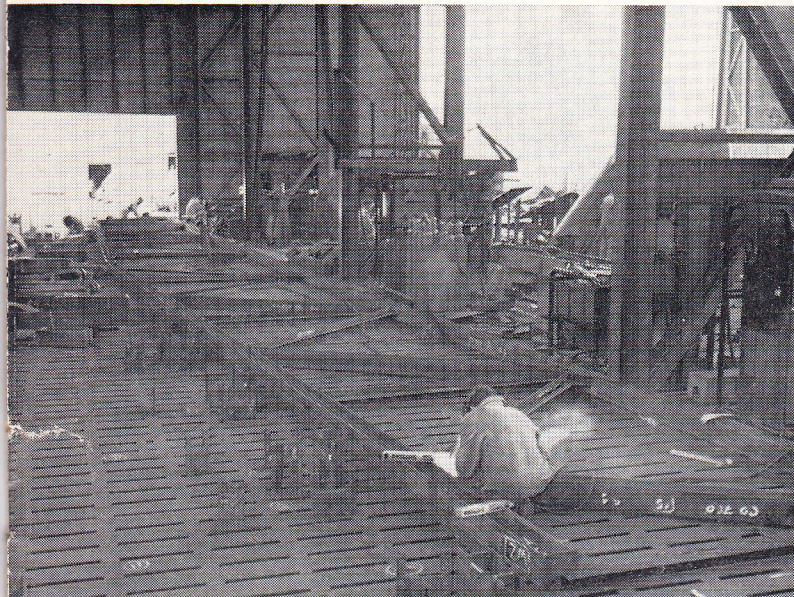
Een vet laskarwei voor J. Mager is dit kapspant van 35 meter.
