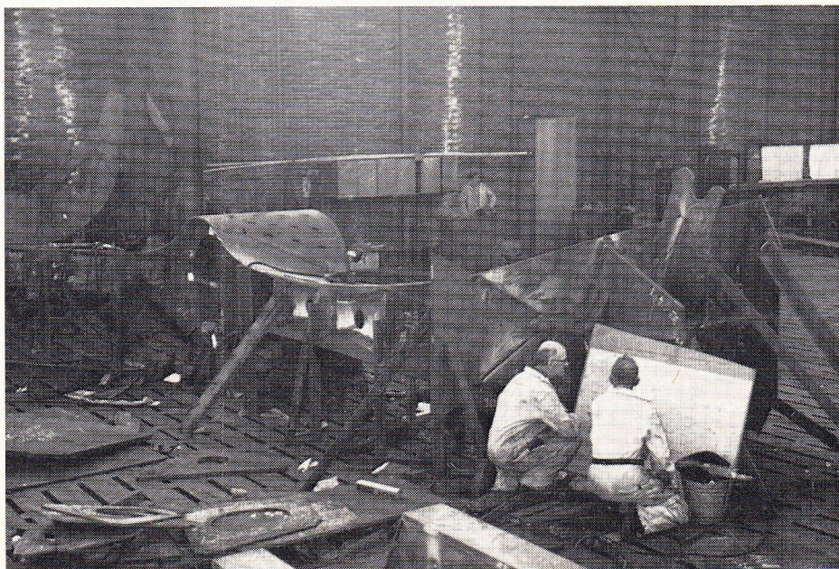
Een achterstev in aanbouw voor Demka. (CO 270). Op de voorgrond bestuderen P. Bode (l.) en P. Kooyman een tekening van een roer voor dezelfde maatschappij. (CO 271).
