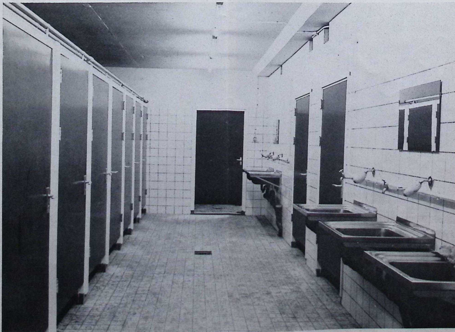
Het toiletgedeelte onder nieuwbouwhelling I
