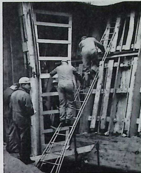
De afschrijvers H. M. Slegt (onder op de ladder), C. J. Gerritse (boven) met hun maathelpers W. Boudewijn en A. Bodegom (gedeeltelijk zichtbaar achter de mal) nemen maten op, terwijl de werkvoorbereiders B. Terlouw en H. F. J. Leentvaar de te vernieuwen onderdelen in tekening brengen.
