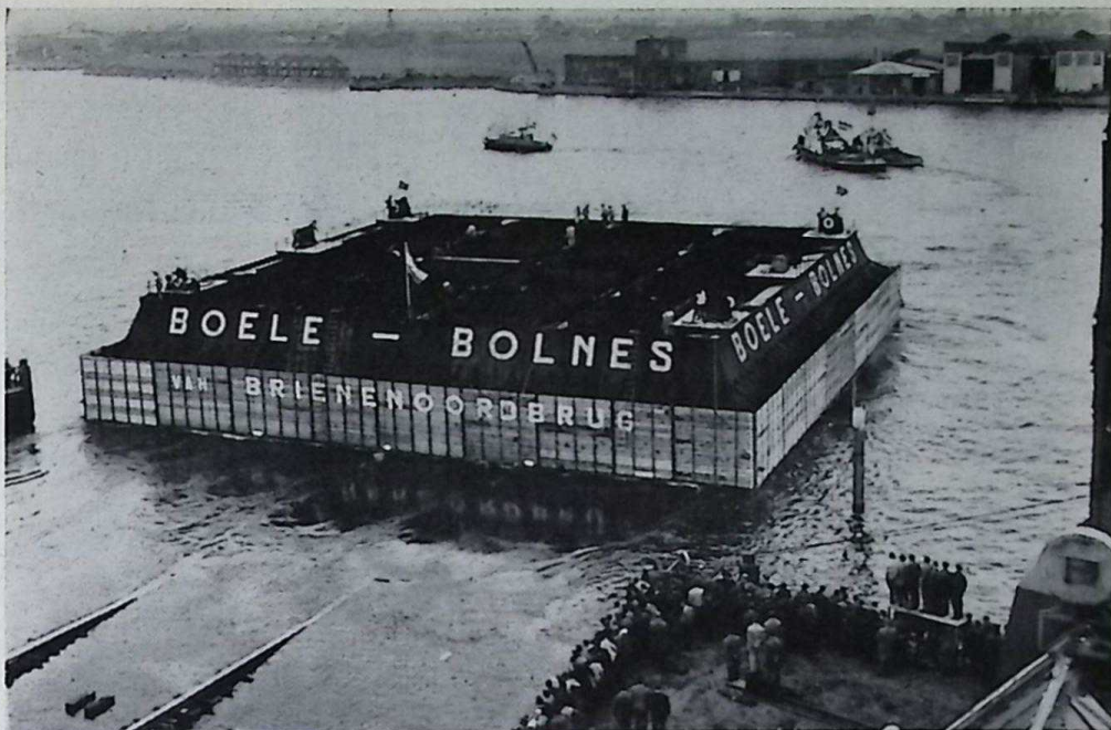
De tewaterlating van de eerste calsson op 24 april 1961.
