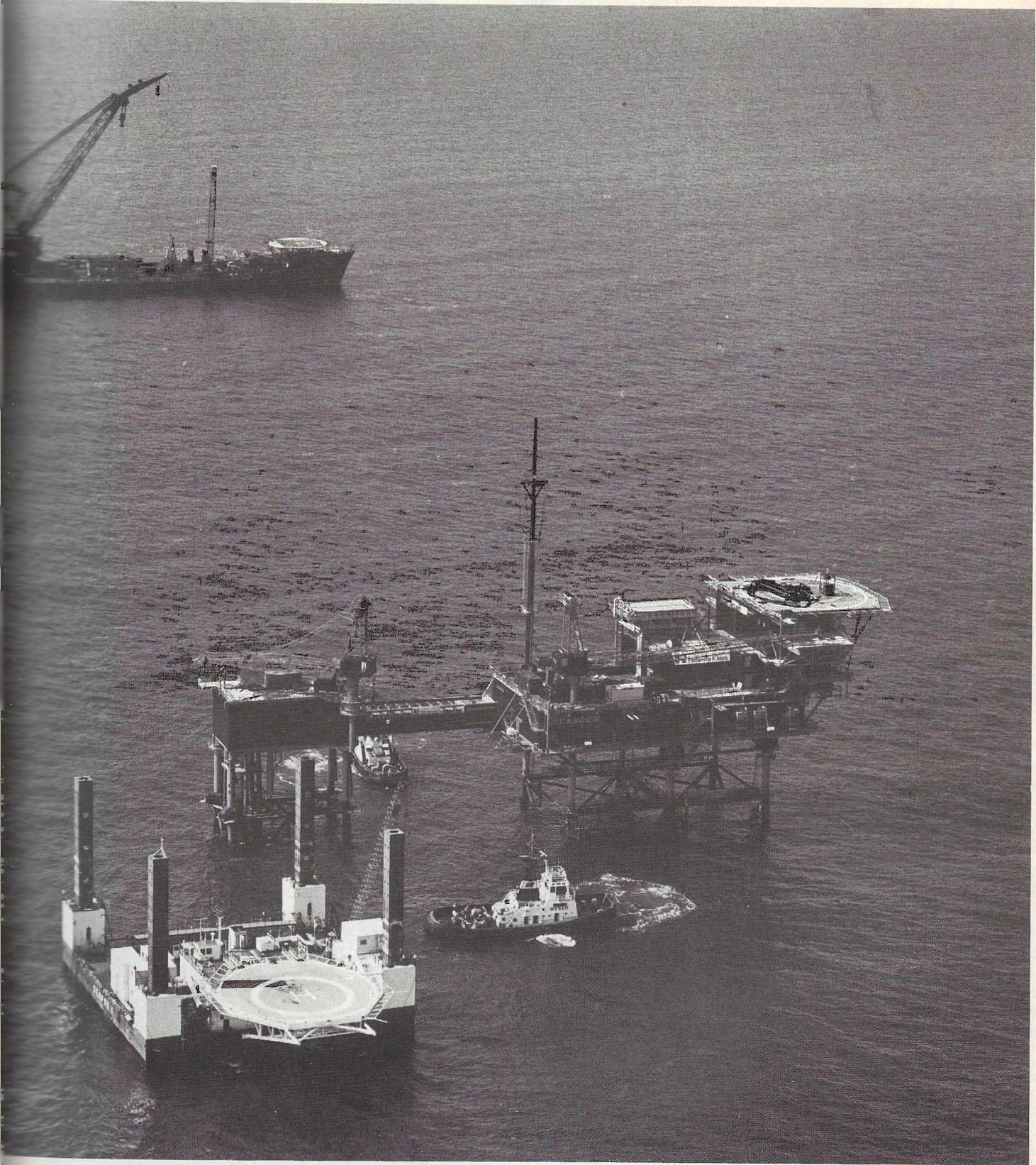
Een foto, waarop alles Boele is, wat de klok slaat. De door ons gebouwde „Challenger” heeft zo juist woonruimte II achterop platform K7 geplaatst en vaart weg. Ons bouwno. 1068 – de „Seafox 1” – staat in de onmiddellijke nabijheid voor onderhoudswerkzaamheden.
