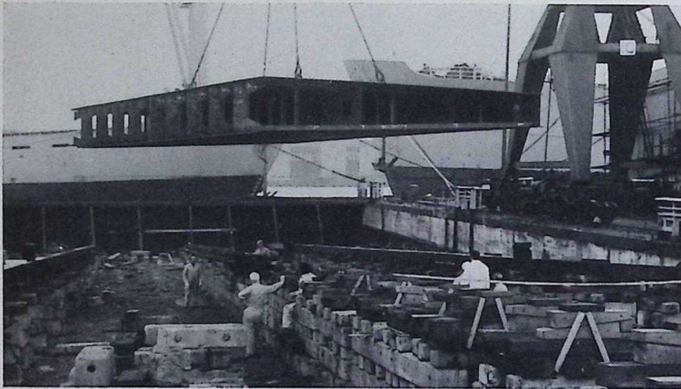
5 augustus: de eerste sectie van de eerste bauxiet-bak wordt geplaatst.
