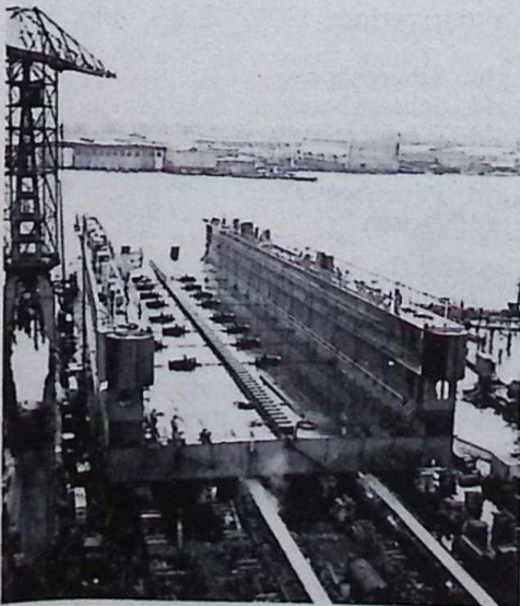
Tewaterlating in drie fasen.
