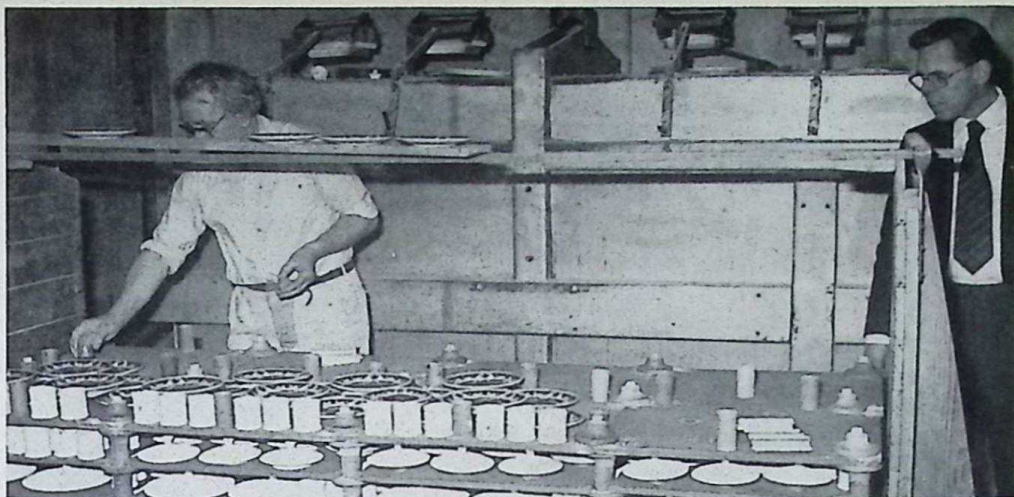
Een stapelrek op vuurvaste ondergrond met daarachter een oven, die er overheen geplaatst zal worden om de inhoud te bakken
