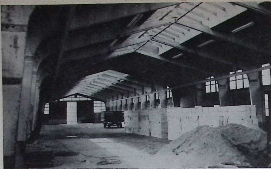
Houtafdeling gaat naar beton.
