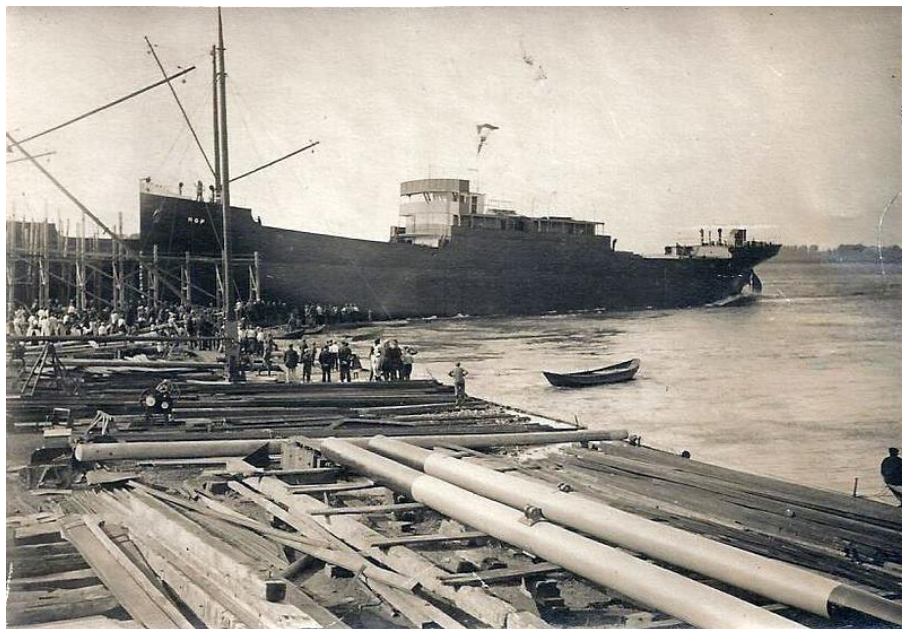
Te waterlating van de "HOP" te Slikkerveer, gebouwd in opdracht van de Gebr. Van Uden, bouwnummer 610. Begonnen met de bouw in september 1915 en levertijd juni 1916. Tekeningen en foto werden gevonden door zijn achterkleinzoon Quincy op de zolder van de botenloods te Slikkerveer, 29 mei 2014. Op 4 februari 1940 is de "Hop" getorpedeerd door de "U37".
