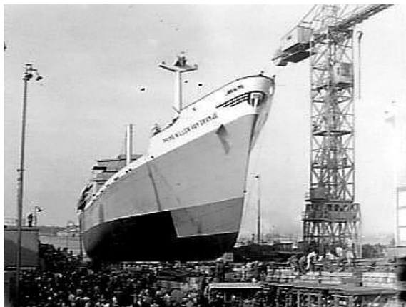
Tewaterlating in 1953 van de Prins Willem van Oranje. (het model stond eerst op de werf en nu op de Ringdijk 454)
