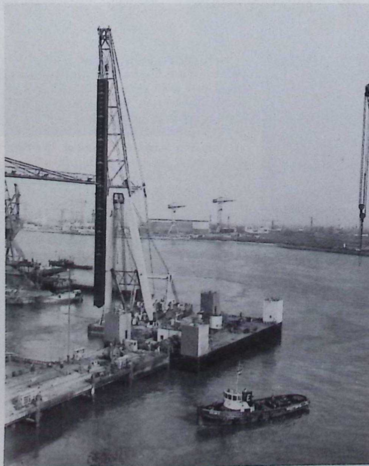
De eerste paal werd op 18 april geplaatst.
