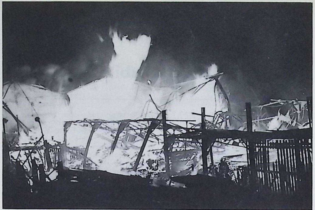
Deze grote brand werd aanleiding tot het stichten van een bedrijfsbrandweer. Het waren twee houtloodsen, die in de nacht van 5 op 6 juni 1939 volledig afbrandden.
