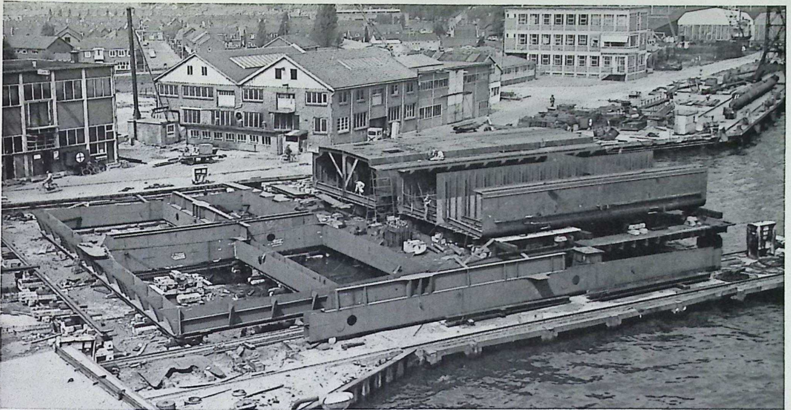
Lasvloer Oost — buiten. Zusterlijk vereend de secties voor de verlenging van „Argovia” en „Caucasia”. Daarvóór luikhoofd 4 van de „Beaveroak”.
