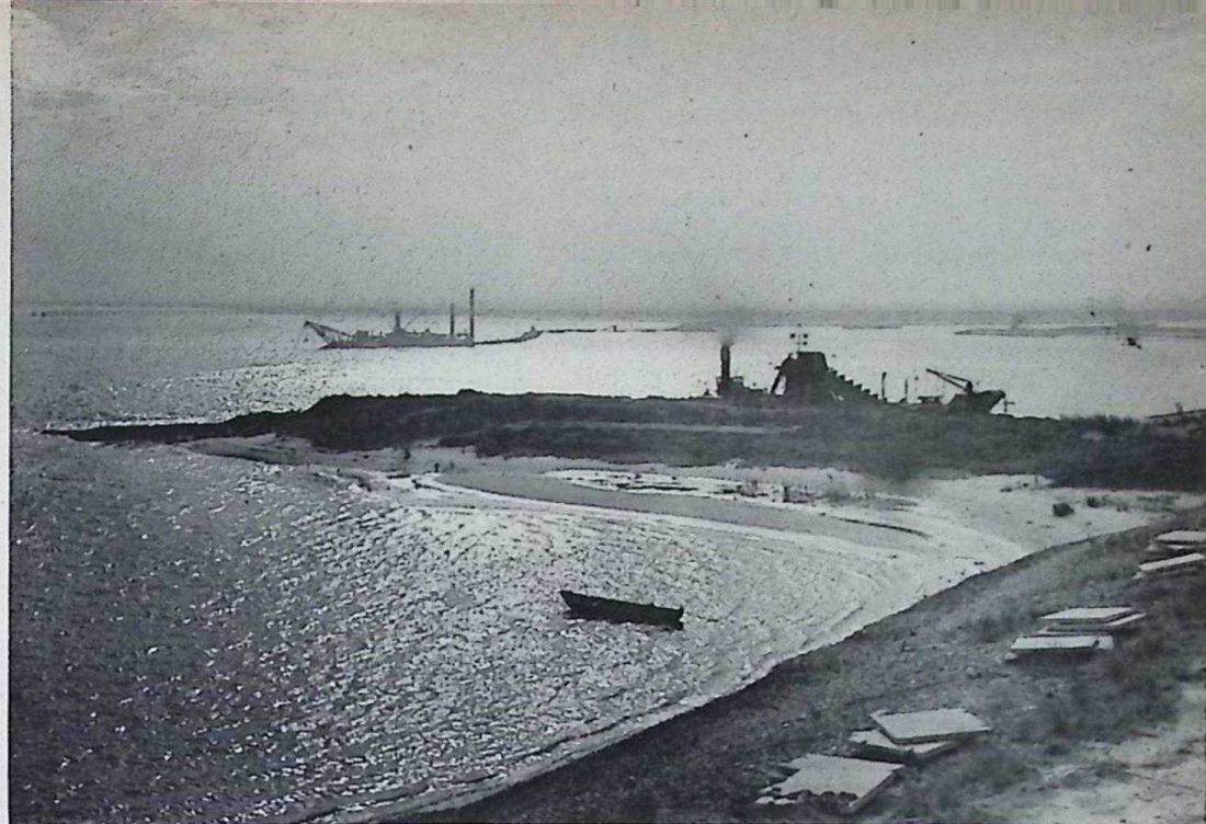
De Deltawerken zullen de waterstanden wijzigen. (Foto werd gemaakt nabij de spuilsuizen in het Haringvliet).
