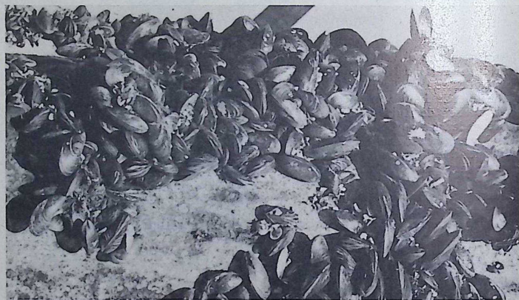
Een dikke laag mosselen bedekt het staal, dat steeds onder water geweest is.
