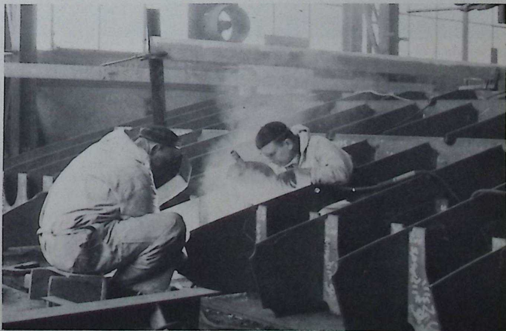
Arbeid aan de 1e sectie van bouwno. 963. Links: W. Pottuit — rechts F. de Jong.
