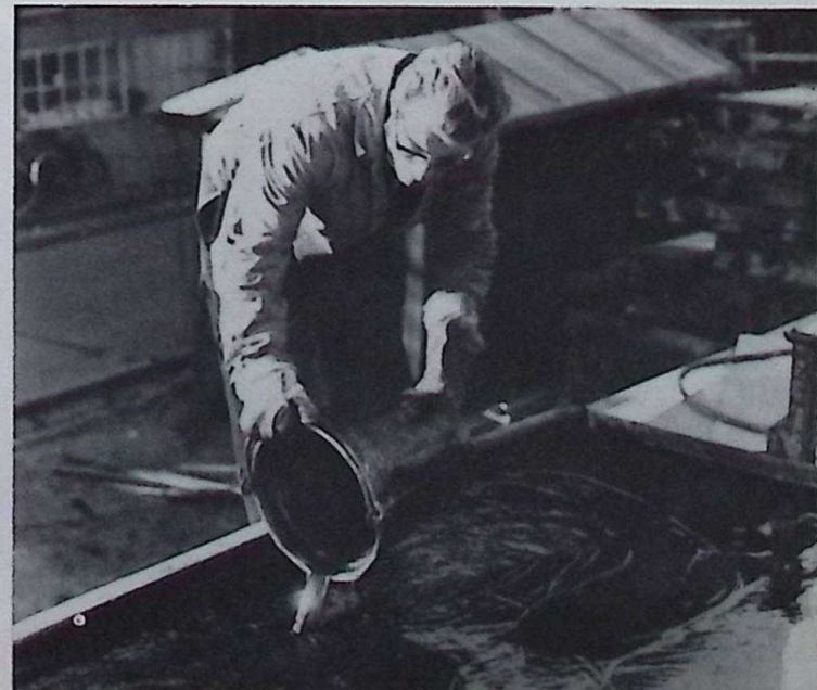
Het ingieten van heet vet, het z.g.n. basekote. (J. L. Leentvaar)
