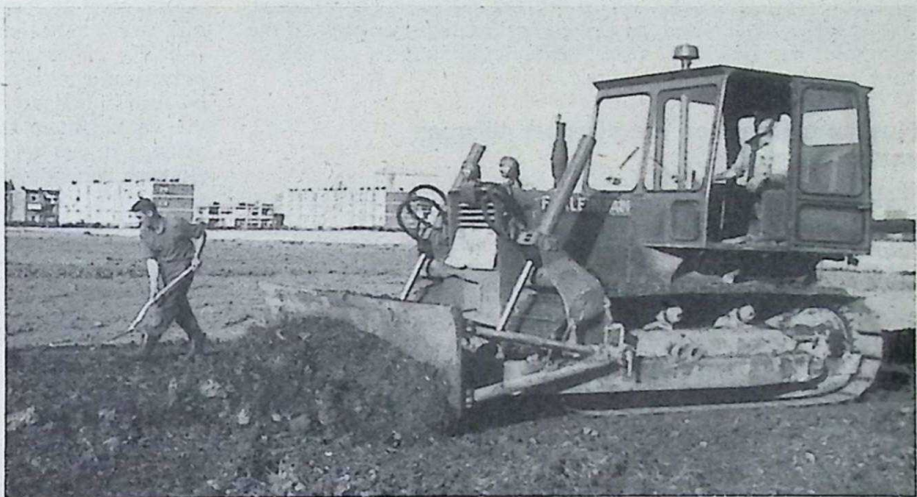
Met de aanleg van het sportveld werd een begin gemaakt.
