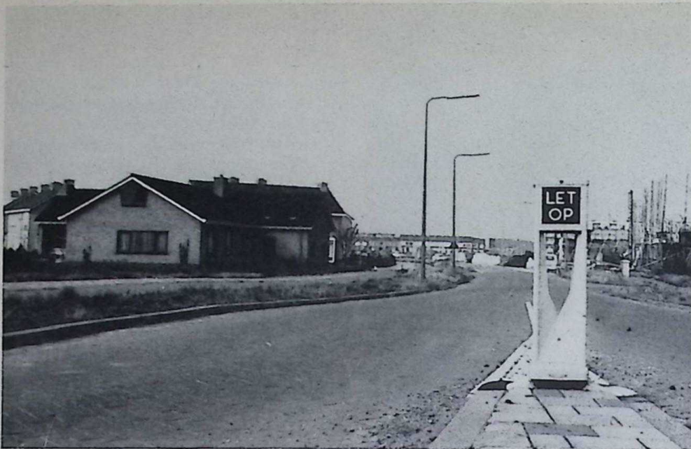
Let op! Dit is de burgemeester de Zeeuwstraat. Links de bungalow van de Heer P. Koutstaal. Rechts de in aanbouw zijnde woningen.
