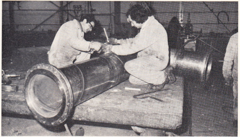
Pijpwerk in de koperslagerij.
