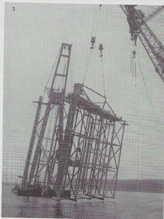
De maalbak (of onderbalk) dient als geleiding van de trilmaasden en bevindt zich in de beun van de ponton. Als de trilmaasden naar de bodem gevierd worden, zakt de naaldbalk mee naar de diepte. Op het schilderij is dat mooi te zien. De plaatsing vond plaats op 3 juli 1979.
