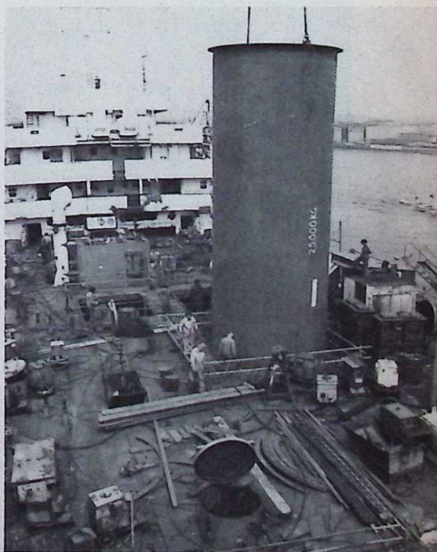
Inbrengen van de kokers voor de Schottels.
