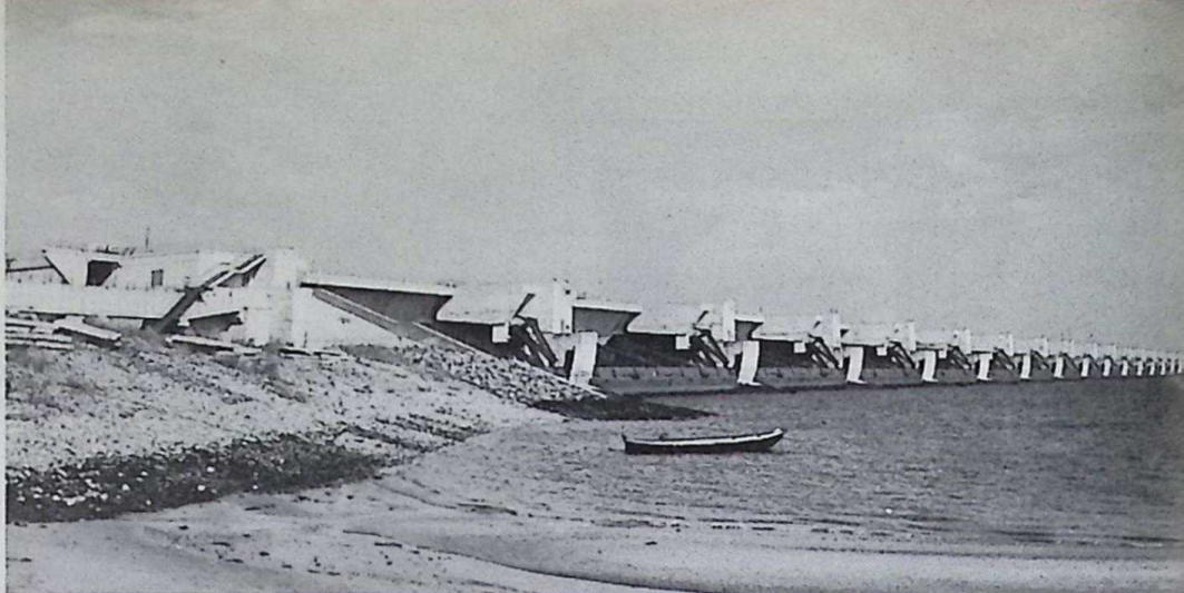
De spuisluizen in gesloten toestand — medio oktober 1968.
