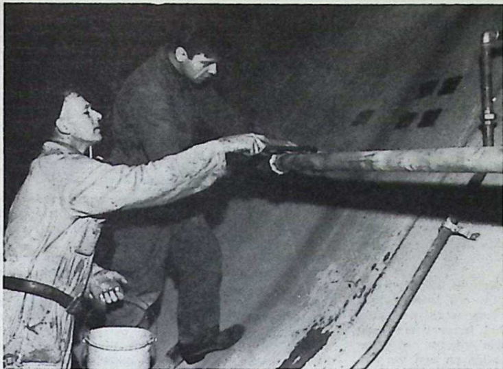
Het zeepsoppen van de leidingen voor lekkagecontrole. Links J. P. Kievit, rechts P. Verbeek.
