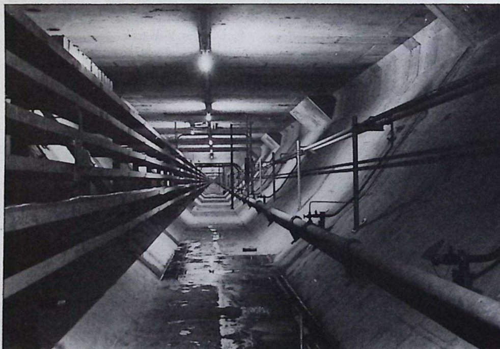
Een gedeelte van de meer dan één kilometer lange sluisstunnel, waarin onze koperslagers de rechts zichtbare leidingen aanbrachten.
