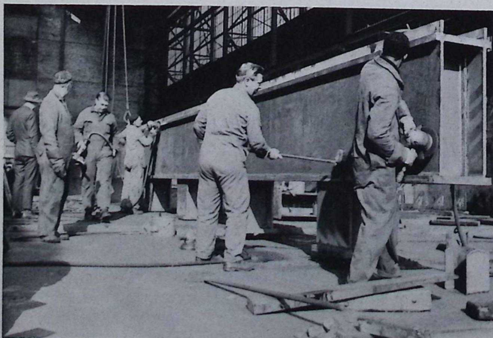
Een balkje van 31 ton. De beschikbare tijd werd beslist niet over de balk gegooid. Deze opname werd 5 minuten voor het transport gemaakt.
