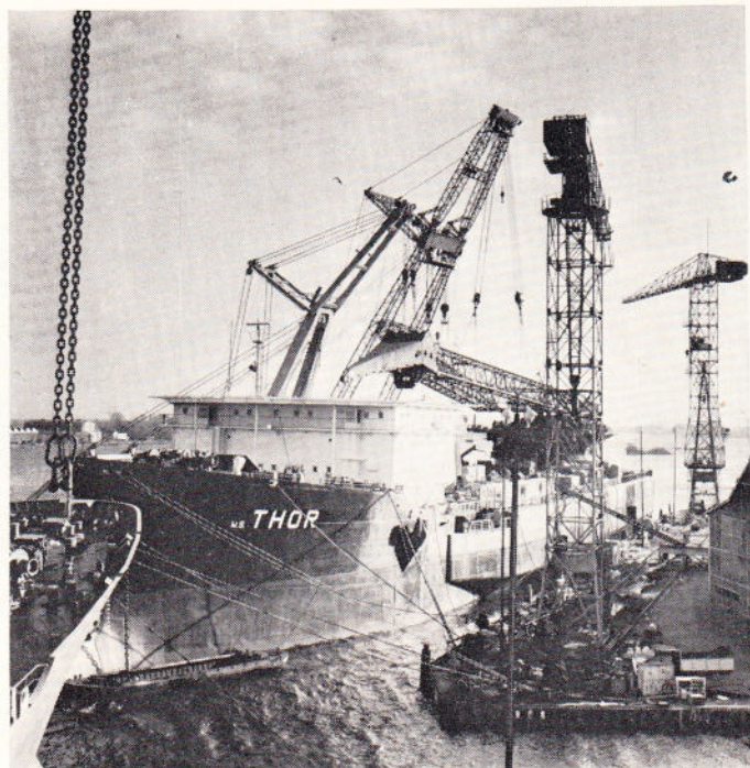
Plaatsing kraanarm op 19 november.
