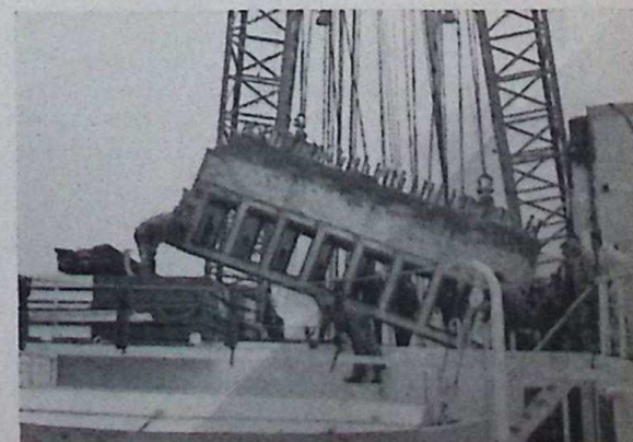
Foto 4: Natuurlijk kon het blok niet rechtstandig omhoog door de schacht en moest voorzichtig gekanteld worden. Hierbij was wat je noemt een schoenlepel nodig om alles vrij te houden.
