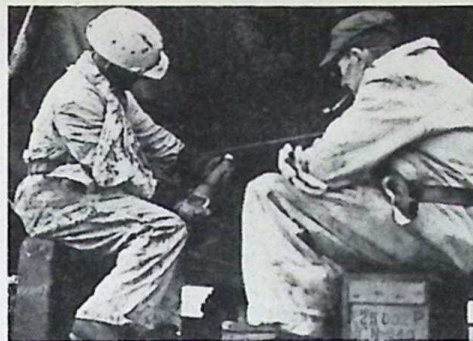
De „Genca" vroeg om 8000 nieuwe nagels. A. Nijholt klikt hier de 7162ste. Zijn helper is B. de Ruitter.
